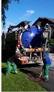
system soll wieder dem aktuellen Stand der Technik angepasst werden. Aus diesem Grund ist eine gründliche Kanalreinigung anschließender Inspektion mittels Kamera voll im Gange und soll nach ca. 4 Wochen abgeschlossen sein. Es gibt die verschiedensten
