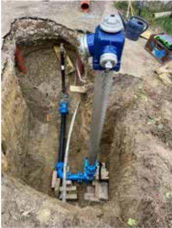
Im Zuge der Instandhaltungsarbeiten an den Wasserversorgungsleitungen mussten wieder einige Salbache und Hydranten getauscht werden.
